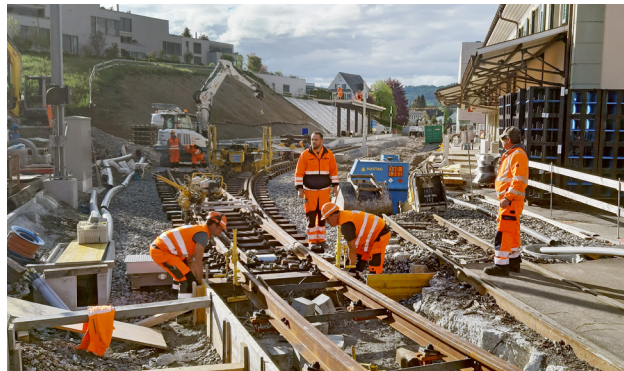
Umbauarbeiten Bahnhof Teufen
