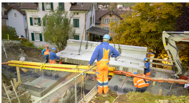
Einbau Brückenplatte «alte Steig», Herisau
