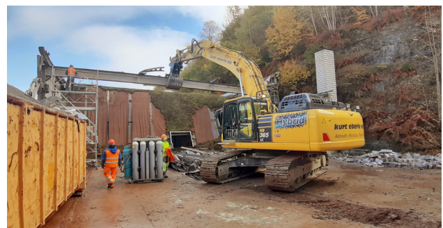
Abbruch Depotteil Werkstatt Herisau
